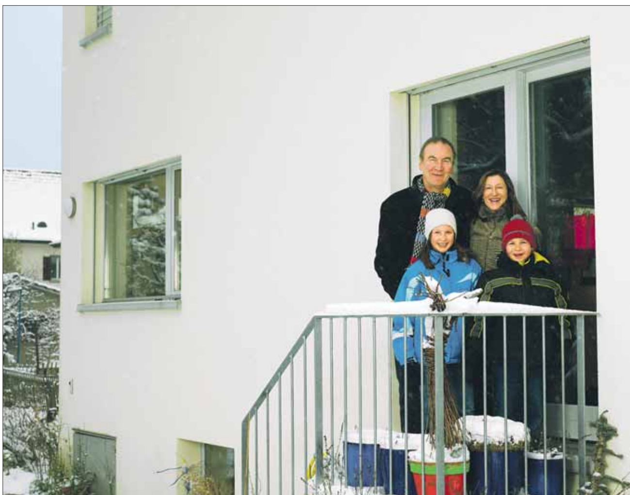
Dieses Haus mit Baujahr 1934 verbraucht nach der Sanierung 80% weniger Erdgas und erreicht nicht nur den Minergie-Standard, sondern übertrifft ihn.
