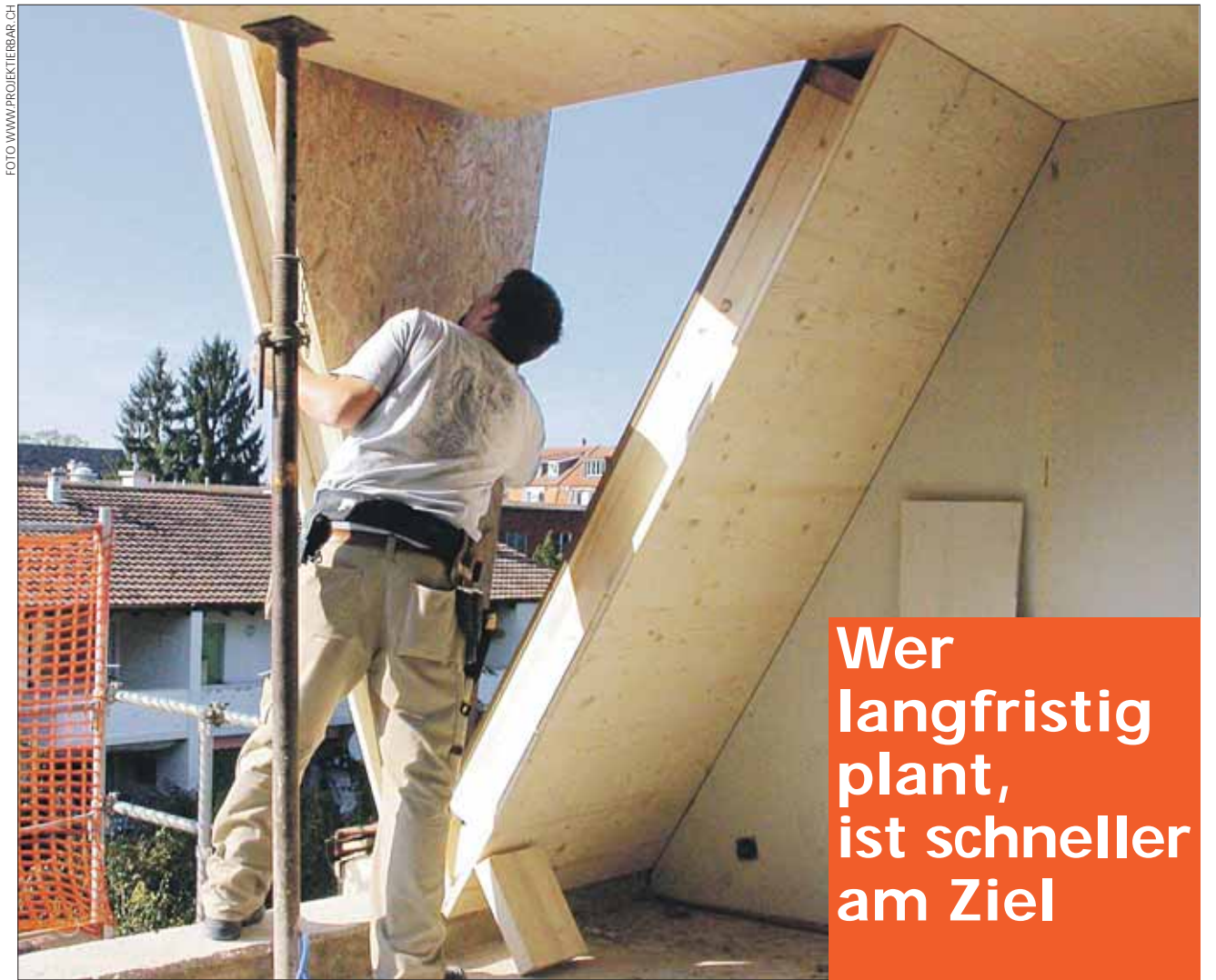
Ausbau des Dachgeschosses eines Einfamilienhauses mit vorfabrizierten Elementen
