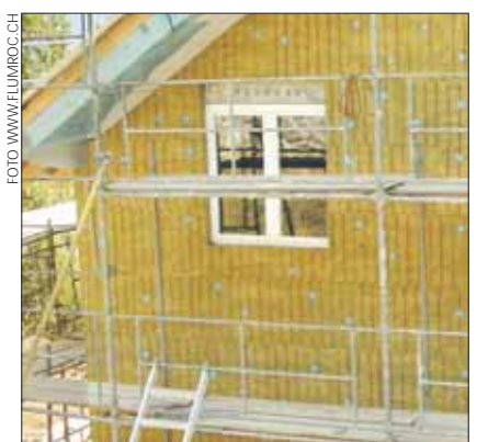
Kompaktfassade vor dem Verputzen
