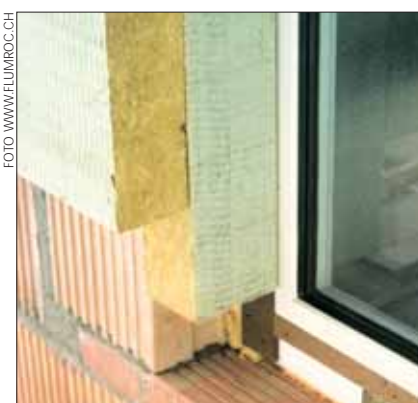
Die Dämmplatten für eine Kompaktfassade werden auf das Mauerwerk geklebt.
