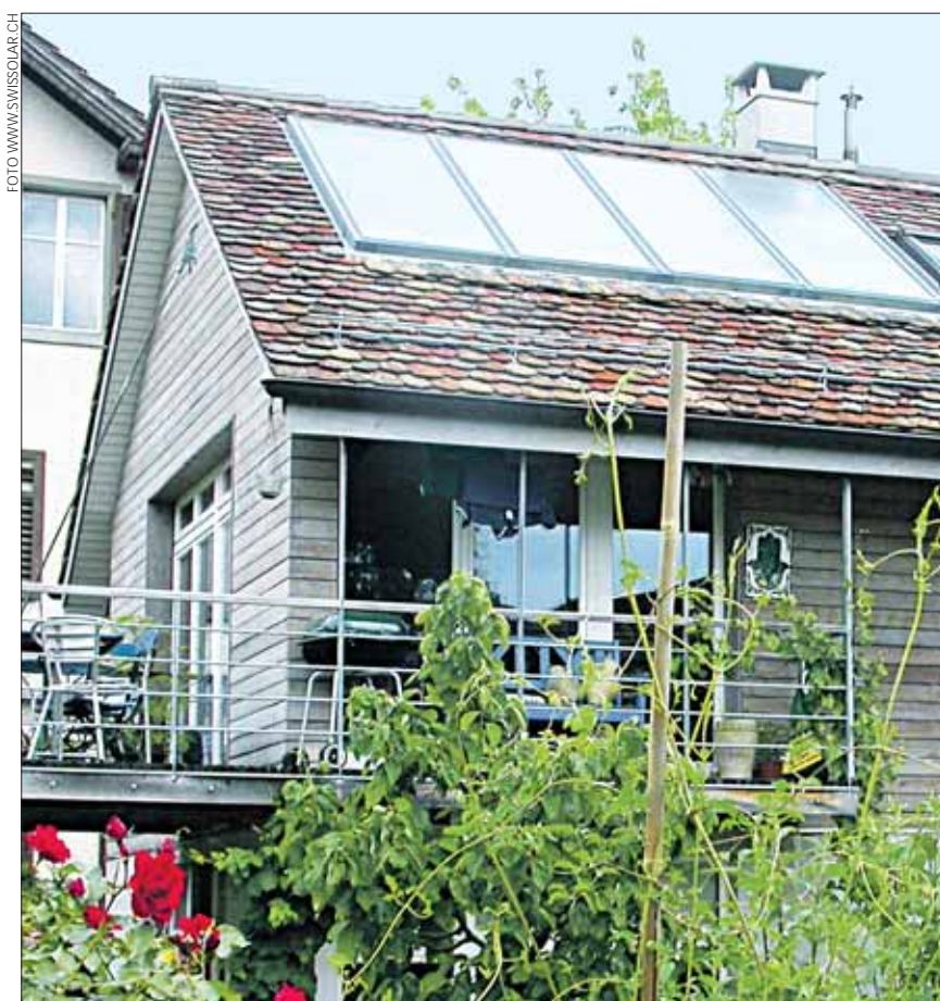
Ein Kompaktsolaranlage für die Wassererwärmung ist innerhalb eines Tages fixfertig installiert.
