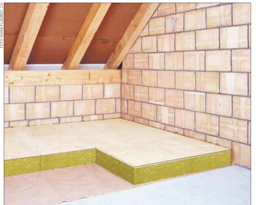
Die Dämmung von Estrichboden und Kellerdecke ist eine kostengünstige Massnahme mit grosser Wirkung
