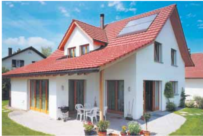
Sonnenkollektoren stehen jedem Dach gut.
