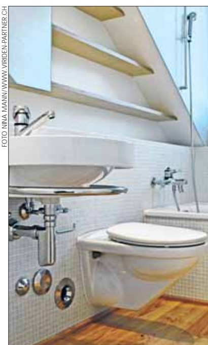
Perfekt bis ins Detail: Einhebelmischer mit Eco-Funktion und Durchflussbegrenzer im Lavabo und Sparbrause zum Duschen
