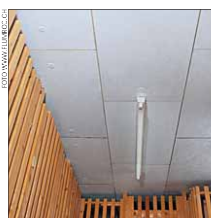
Die Dämmung der Kellerdecke ist eine kostengünstige Massnahme mit grosser Wirkung.
