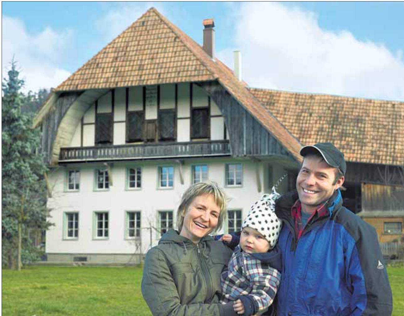
Ende gut, alles gut: Fassadendämmung, Komfortlüftung, Holzschnitzelheizung, Wärmeschutzfenster und eine neue Küche.
