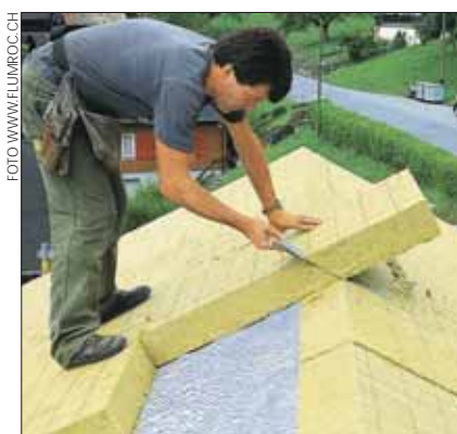
Der flache Grund erleichtert die Montage bei der Aussendämmung.
