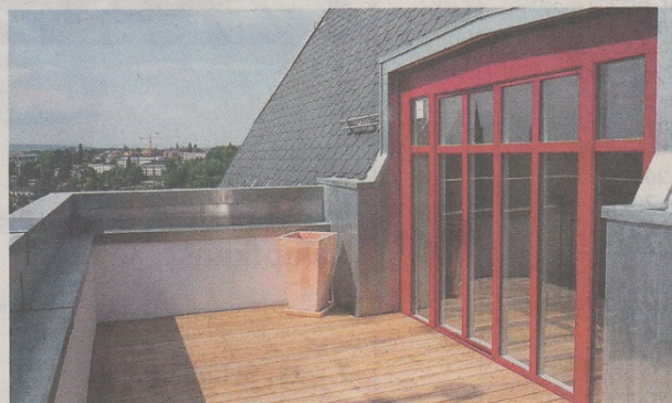
Die Dachterrasse, hinter dem Deckenturm, welche von aussen nicht sichtbar ist.
