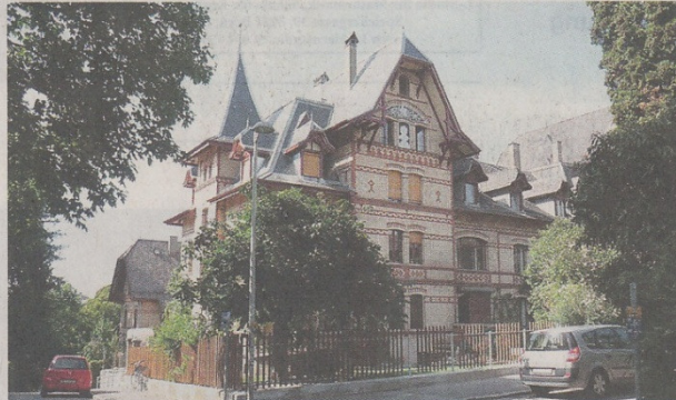
Das renovierte Haus von Charlotte Michel am Obstbergweg 2 in Bern.
